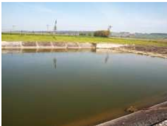
Stará požární nádrž
