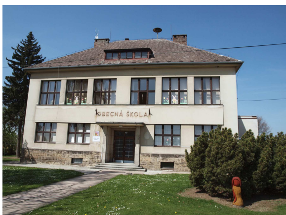
Obecná škola před opravou
