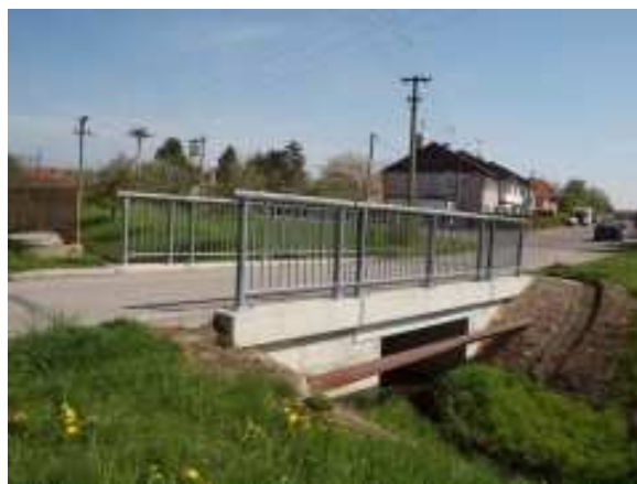
Opravený obecní mostek
