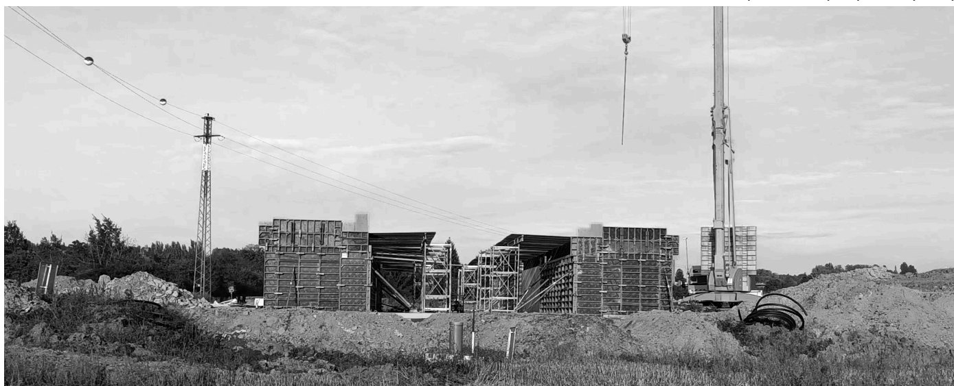
Stavba podchodu pro pěší a cyklisty
