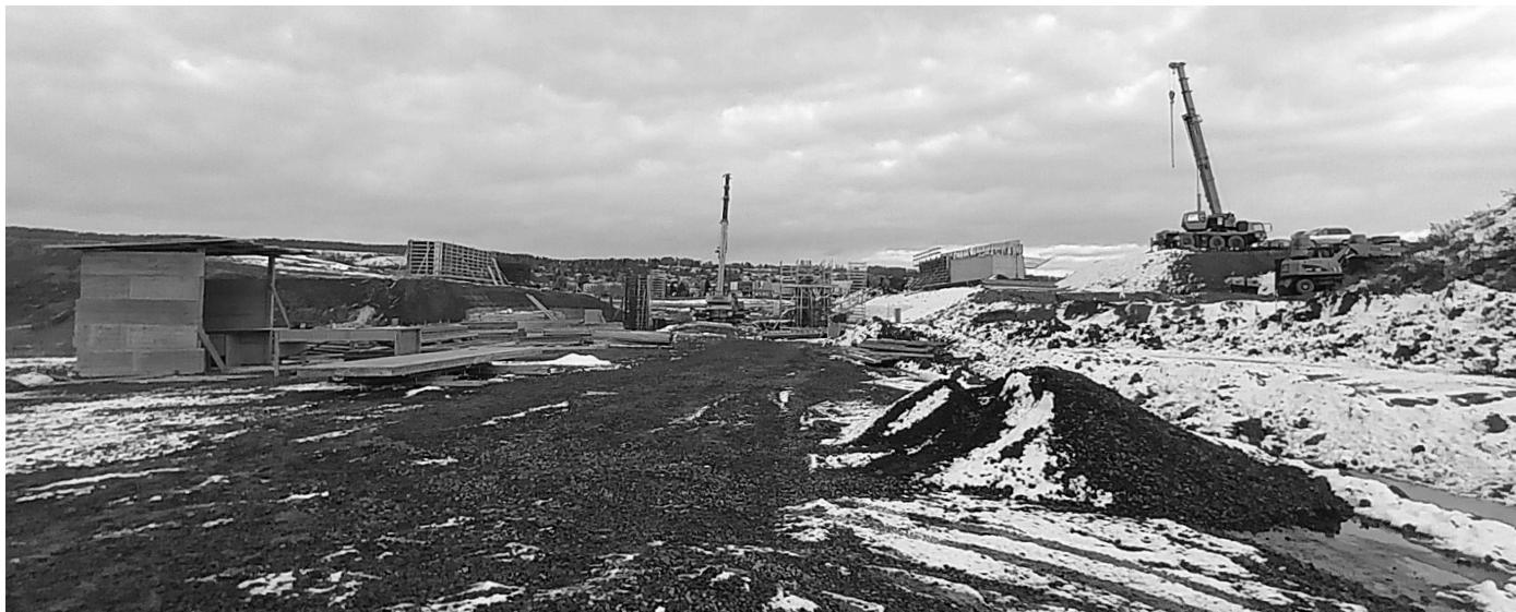
Stavba v místě křížení dálnice s novou silnicí z Dobré Vody.
